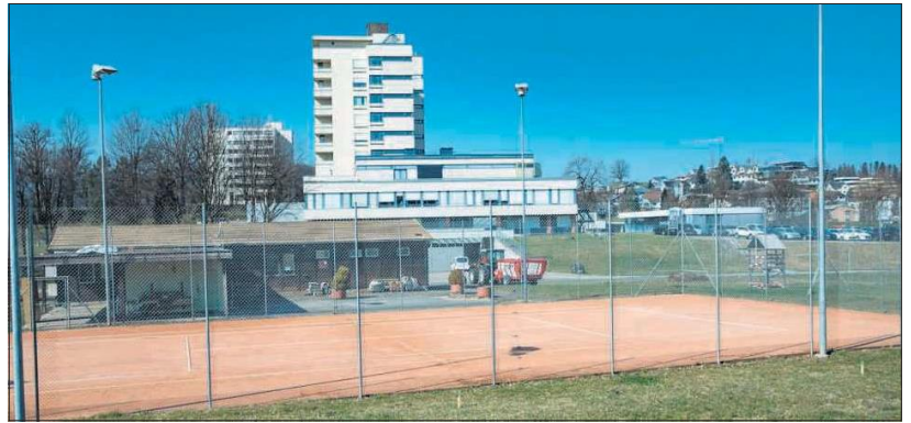
Nachdem bei ersten Umgebungsarbeiten beim Spital Wolhusen Bäume gefällt und Böschungen gerodet worden sind, fahren nächste Woche die Bagger auf. Tennisplätze und Clubhaus werden zurückgebaut. [Bild Bruno Rööslil]
